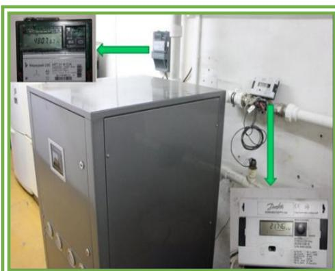
Производительность СК при таком низкотемпературном режиме работы составляет **1 МВт/м<sup>2</sup>** в год. COP TH =3.
