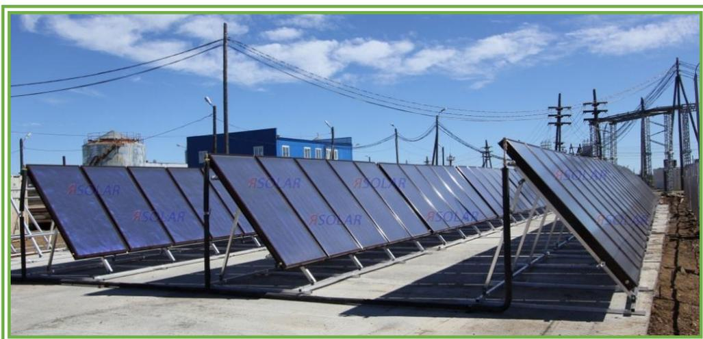
Исходя из тепловой нагрузки объекта, предоставленной заказчиком, (минимум 150кВт), была рассчитана площадь поля солнечных коллекторов 300 м<sup>2</sup>. Расчетная мощность установки при площади абсорбации **300 м<sup>2</sup>** в ясный солнечный день составляет до **180 кВт**. Циркуляция теплоносителя осуществляется насосом мощностью **1,6 кВт**, управляемым частотным приводом.
