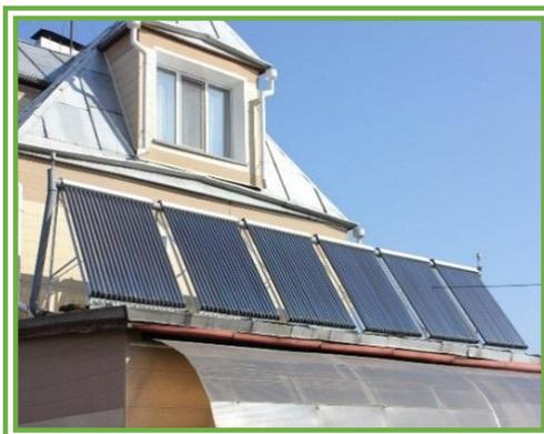
Зимой все **220** трубок работают на подогрев низкого контура ТН и покрывают **15-17%** годового потребления тепловой энергии на отопление.
