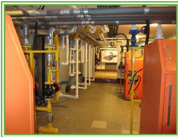
Система работает в автоматическом режиме по заданным параметрам необходимой температуры, оснащена погодозависимым модулем регулировки режимов. Система диспетчеризации, подключенная к Интернету, позволяет не только дистанционно контролировать и диагностировать оборудование, но и производить регулировку важнейших его параметров.
