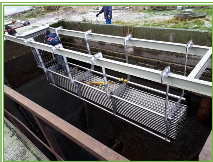
Источником тепла в данной системе являются сточные воды, температура которых круглогодично +12<sup>0</sup> С и выше. Благодаря высокой температуре сточных вод, теплонасосная установка
