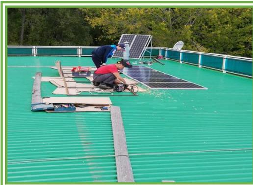
**На втором этапе** в 2018 году было решено добавить 6 панелей поликристалл по 200 Ватт, 4 аккумулятора по 100 Ач и был заменен контроллер и инвертор 1,5 кВт на гибридный инвертор 5 кВт с функцией резервирования от генератора.
