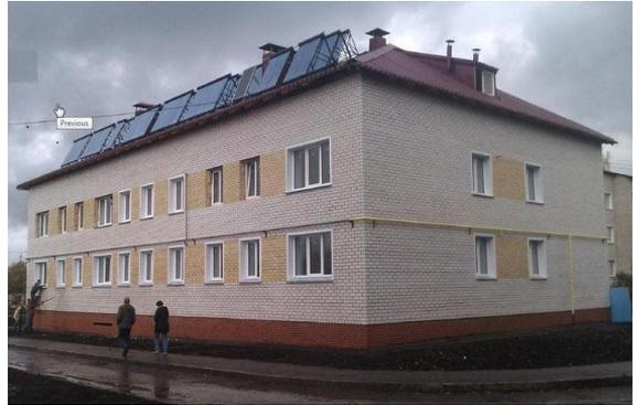
Источник НПП – 9 геозондов. Система работает в комплексе с солнечными коллекторами, поквартирными газовыми котлами.
